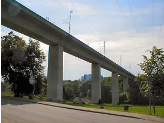
Blick von der Blankensteinstrasse (2007)
