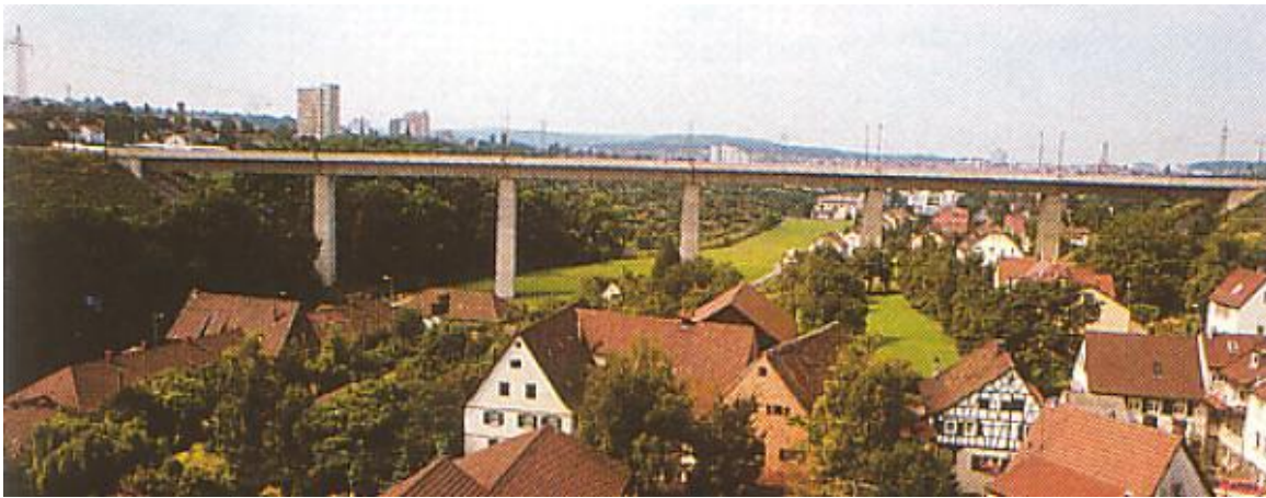
Der neue Eisenbahnviadukt überspannt mit seinen 5 Pfeilern das Feuerbachtal
