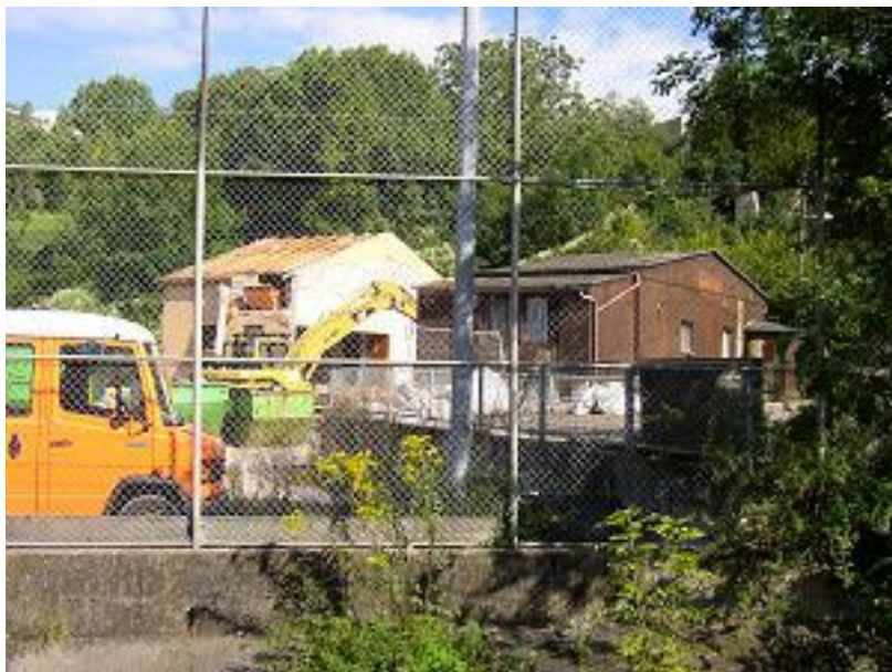
Vom 27.08. bis 09.09.2004 wurde das Gebäude samt umliegender Schuppen abgerissen.
